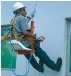
Usa cabo de aço de qualquer comprimento, 4,8 mm de diâmetro;
